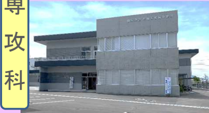
2020年4月 第1期生を迎え入れた新築校舎
